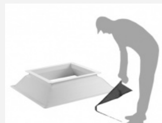
3. Cubrir toda la parte exterior del zócalo con lámina impermeable.
